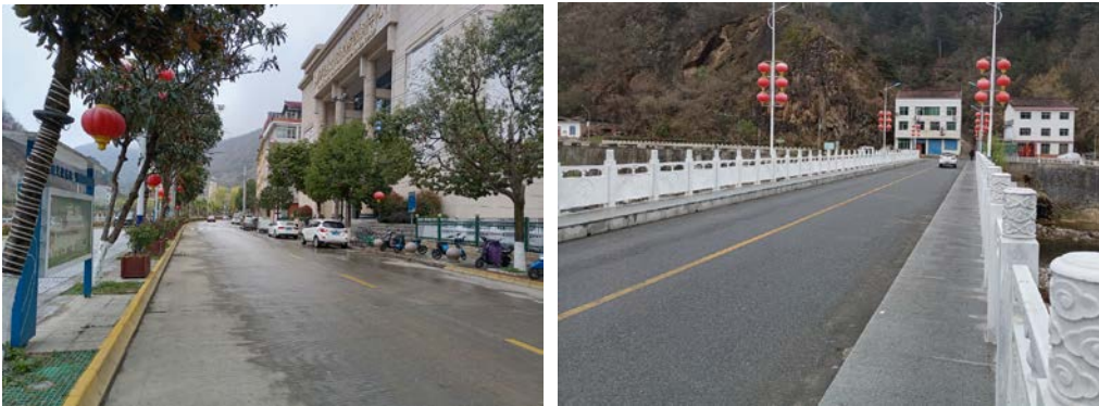
图 1-6 佛坪县城至城北大桥段路线现状
