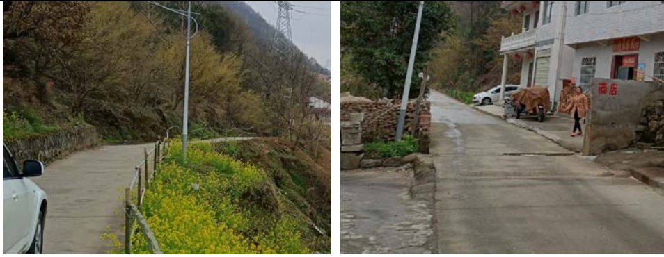
图 1-8 教场坝至两河口段路线现状
